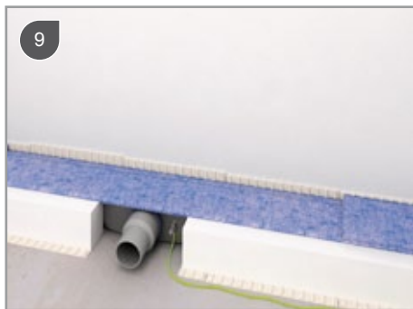
Подсоедините провод заземления к сливу
