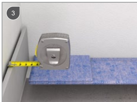
Измерьте толщину плитки *
