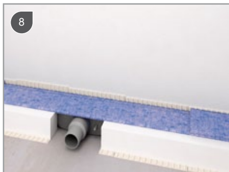
Установите слив на монтажный блок
