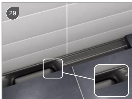
Уберите профиль использованный во время облицовки
