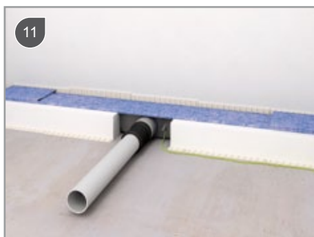
Подсоедините сливную трубу Ø40 мм
